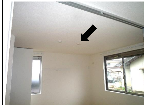
洋室の照明器具設置箇所
