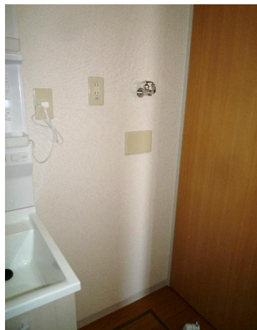
洗濯機置き場
